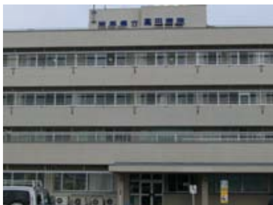
写真 2-1 震災前の岩手県立高田病院
