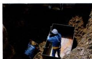
写真⑤ 首都圏から持ち込まれた廃油入りドラム缶(地下約5mの所から218本発見。発ガン性物質トリクロロエチレン等が含有)。
