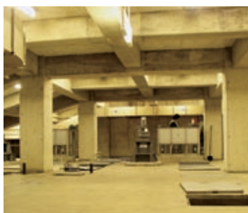
地下汚水処理施設。床穴の下に汚泥タンクがある
